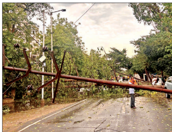
बिजली का खंभा टूट गया।
