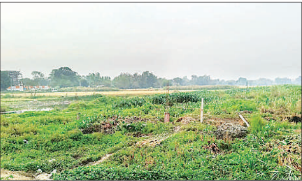
टेढ़ी नदी के कछर पर उड़ाए जा रहे पिलर ।
