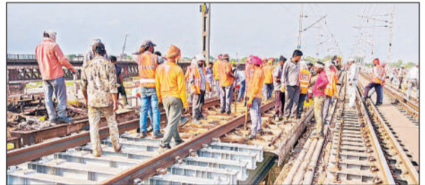
रेलवे पुल के डाउन लाइन पर एचबीम स्लीपर लगाते कर्मचारी।
