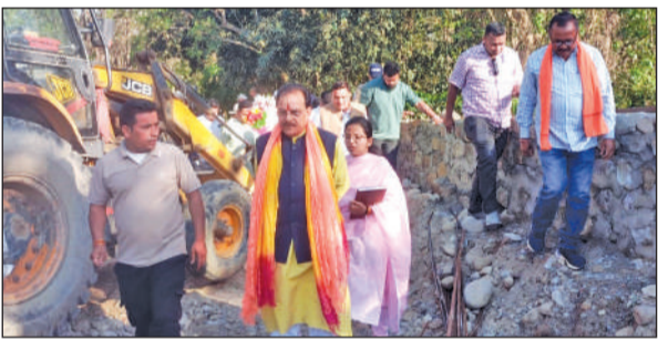
चोरगलिया में निर्माणाधीन पुल के निरीक्षण को पहुंचे सांसद अजय भट्ट व अन्य।
