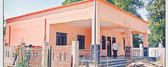
उपनिबंधक भवन का चल रहा निर्माण कार्य।
