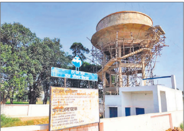
जल जीवन मिशन के अंतर्गत निर्माणाधीन टैंक।
