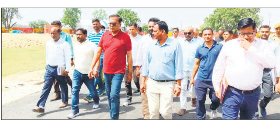
स्पोर्ट्स स्टेडियम में निर्माण कार्यों का निरीक्षण करते डीएम धर्मेंद्र प्रताप सिंह।
