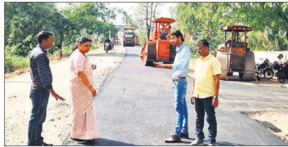
सड़क निर्माण का निरीक्षण करती नगर पालिका अध्यक्ष लक्ष्मी देवी गुप्ता।
