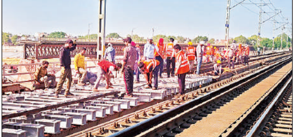
रेलवे पुल पर एचबीम स्लीपर लगाने का होता काम।
