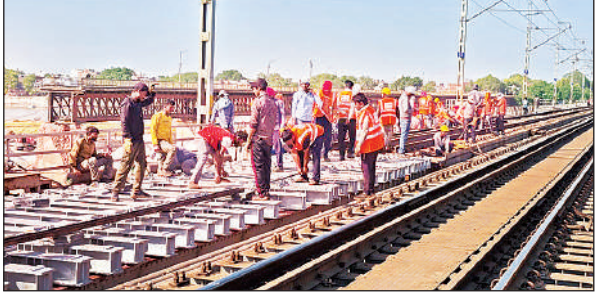
रेलवे पुल पर एचबीम स्लीपर लगाने का होता काम।
