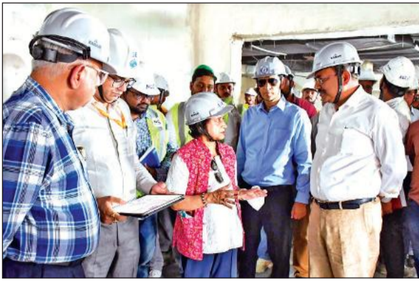
किष्का में निर्माणधीन एम्स का निरीक्षण करते मुख्य सचिव आनंद वर्धन।
