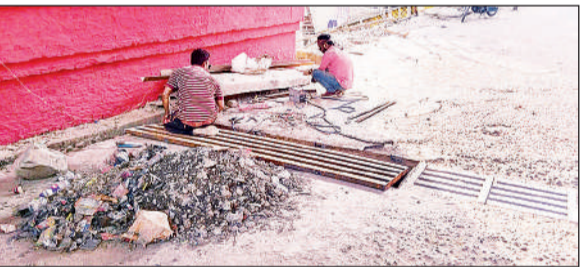
रेलवे पुल के नीचे टूटे क्रॉस की मरम्मत करते कर्मचारी। ● अमृत विचार
