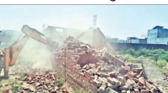
निर्माणाधीन प्लॉट की बाउंड्रीवाल ध्वस्त करता बुलडोजर
