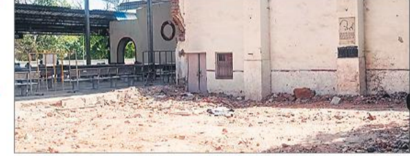
रेलवे स्टेशन पर तोड़ी गई बिल्डिंग की खाली पड़ी जगह।
