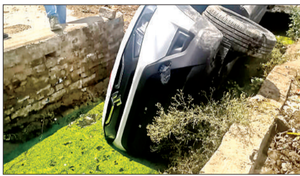
सड़क किनारे खुले नाले में गिरी कार।
