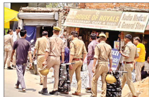
अवैध निर्माण हटवाती पुलिस।
