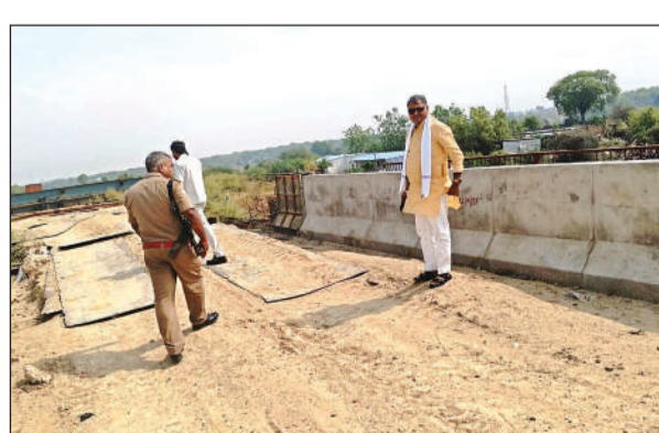
निर्माणाधीन पुल का निरीक्षण करते सदर विधायक डा. मनोज प्रजापति।
