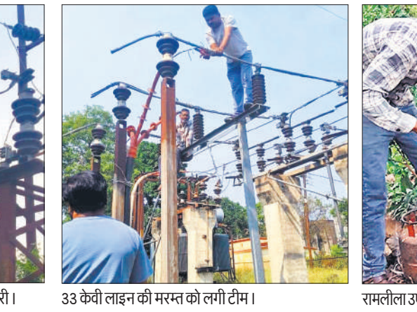
33 केवी लाइन की मरम्मत को लगी टीम।
