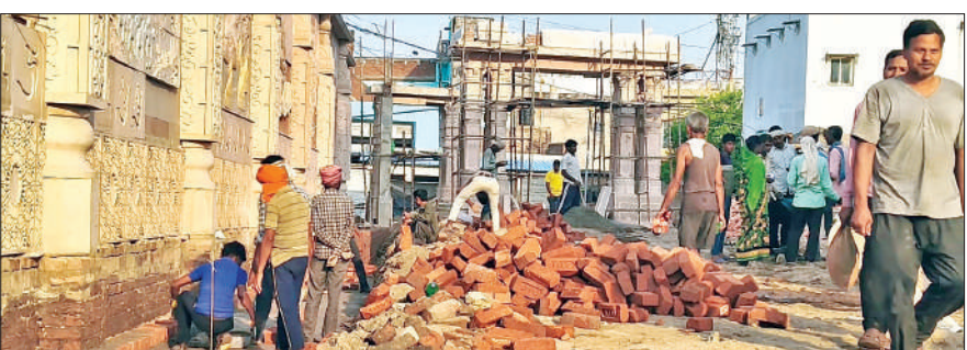
गोला में निर्माणाधीन पाथवे के किनारे नाली बनाते श्रमिक।
