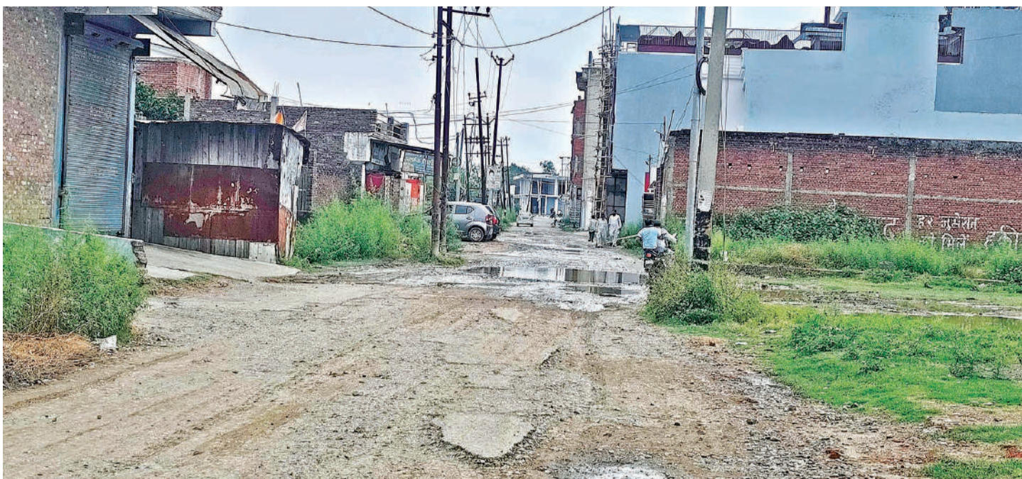
बहेड़ी बाईपास से टुक यूनिन को जोड़ने वाली इस सड़क की बदहाली शहर के माथे पर बदनूमा दाग की तरह है। सड़क पर गड्डे हैं और पत्थर उखड़ कर फैले हुए हैं। गड्डों में पानी भरा है, जिससे पैदल चलना मुश्किल है, मगर अफसोस नगर पालिका का ध्यान इस ओर नहीं है। सड़क के आसपास रहने वालों के लिए यह मुसीबत से कम नहीं। जनप्रतिनिधियों को भी इस सड़क के बारे में लोगों ने बताया, लेकिन इस ओर गौर नहीं किया गया। नगर पालिका की ईओ को इस सड़क के खस्ता हाल होने की जानकारी है। उन्होंने जेई (सिविल) से इसको बनवाने के लिए कहा भी, लेकिन यह सड़क कब बन पाएगी, यह कहना मुश्किल है।
