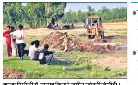
कस्बा सिरौली में तालाब किनारे जमीन खोदती जेसीबी।
