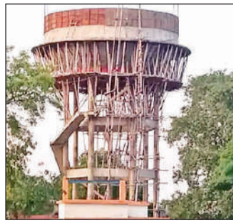
निर्माणाधीन जलजीवन मिशन की पानी टंकी।
