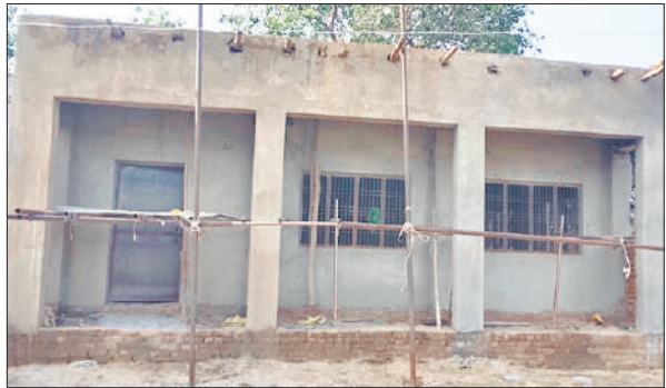
किसान भवन की निर्माणधीन बिल्डिंग।
