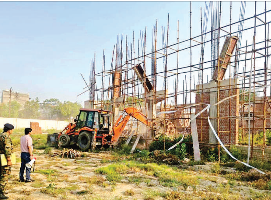
अवैध निर्माण पर चलता केडीए का बुलडोजर।
