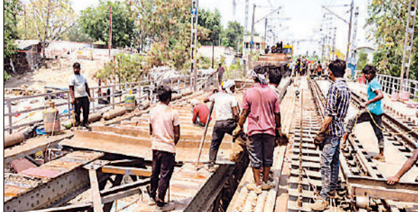
रेलवे पुल के डाउन ट्रैक पर होता एचबीम का काम।
